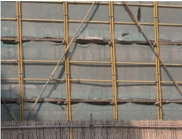
建地は鋼管2本組み
