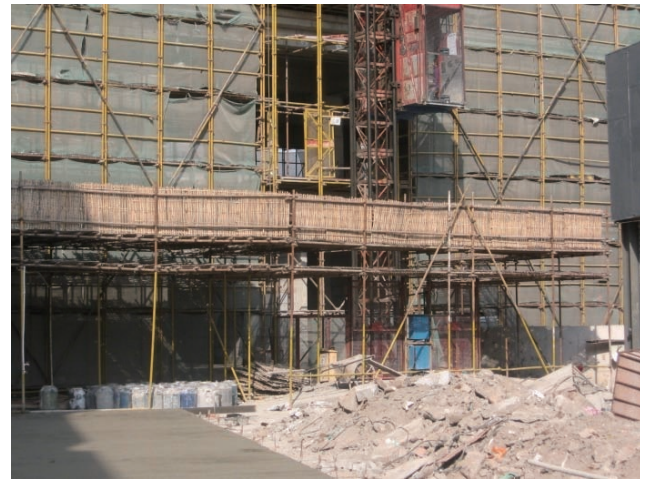
手すり部に竹を配置
