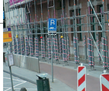
自転車専用レーン脇の足場
