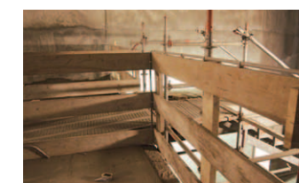
木材のみで組まれた墜落防止柵
