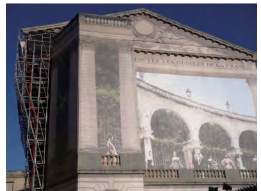
ヴェルサイユ宮殿の外壁修繕工事
