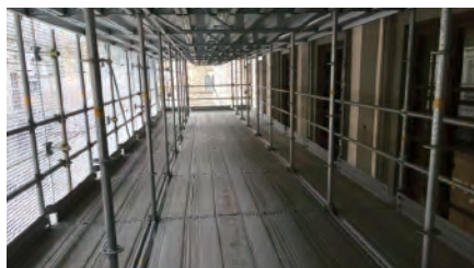
足場内部の様子
