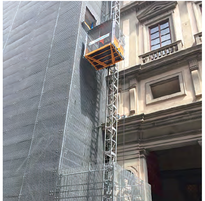
ウフィツィ美術館の外壁工事の様子
