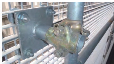
内部から見たフレームの取付け部
