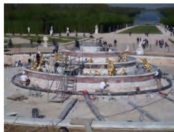
噴水庭園の工事の様子
