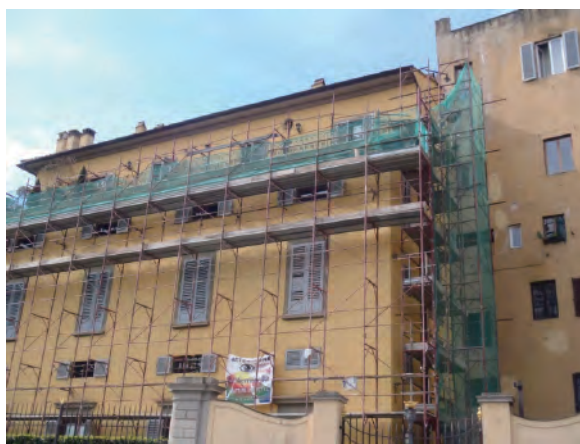
フィレンツェのわく組足場
