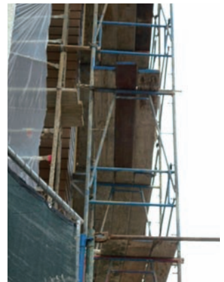
図13 足場板を番線等で緊縛していない
