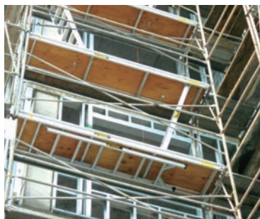
図11 木製のタラップ付きの作業床 ジャッキ型ベース金具と敷板
