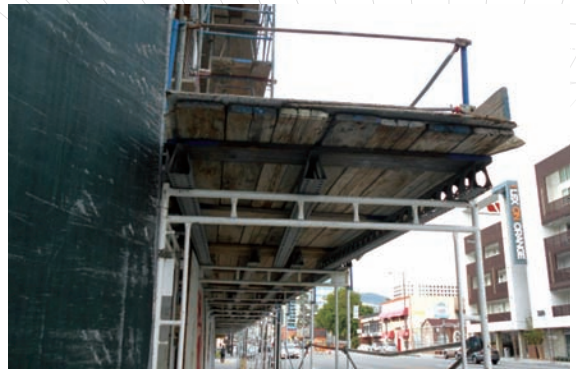
図12 荷受け手摺りの高さが50cm程度で妻側の幅木がない。
