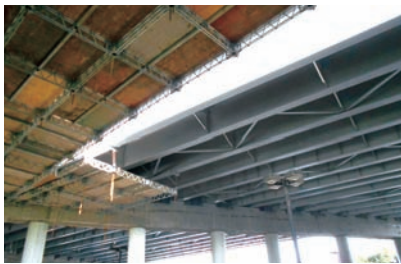
つり足場 (左) と施工済の高架橋 (右)
