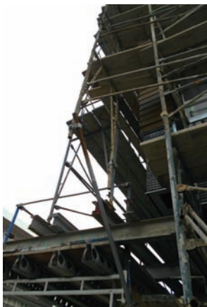
隣接する建わくの脚柱から単管で頼杖をとり、建わくが片持ち状態で組立てられている。
