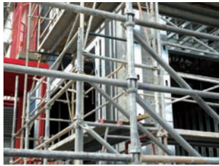
枠組足場と支保工材の 組合わせた足場
