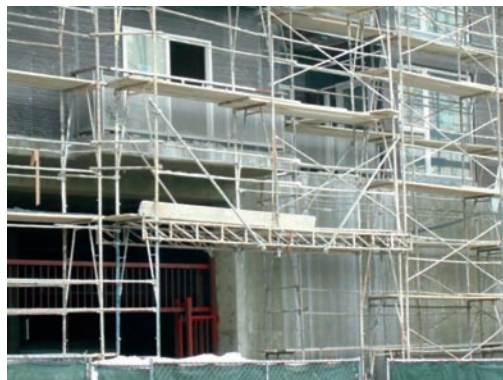
メッシュシート、幅木の設置がない足場
