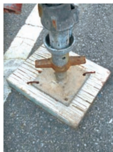
図11 木製のタラップ付きの作業床 ジャッキ型ベース金具と敷板
