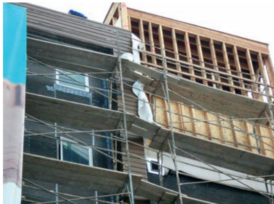
間隔が開いたスパンには足場板が掛けられているのみとなっている。
