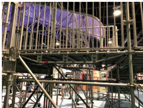
図4 はりわく上に直接、梁間方向（日本では桁行方向）に作業床をスパンいっぱいにつまみつけた作業通路と枠形状の機材
