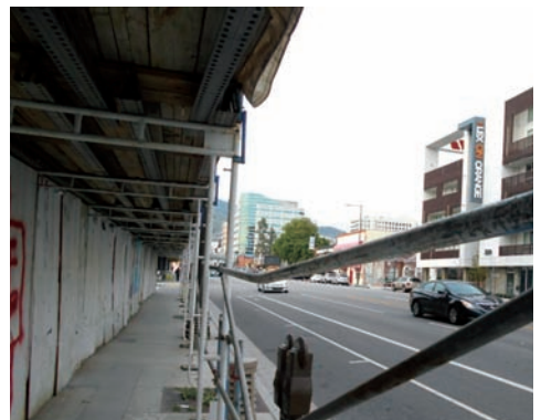
手すり材が曲がった状態で使用している。
