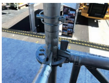
上側に溶接された斜材が枠形状となった機材を円形フランジに緊結する。
