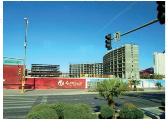
図1 建設中のホテル
