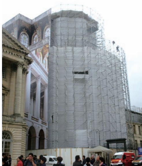
ヴェルサイユ宮殿の外壁補修工事
