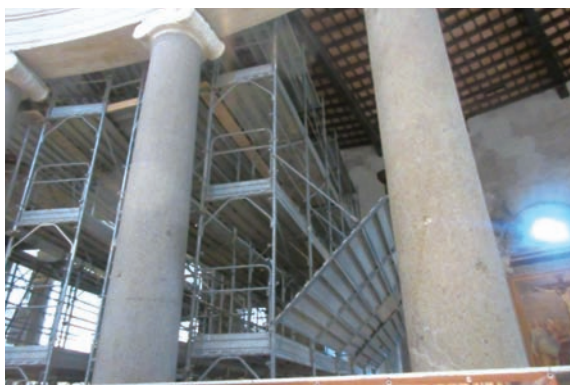
補修工事現場（内部）
