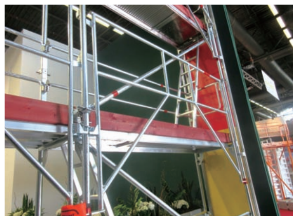
先行手すり（1スパン3.07m）
