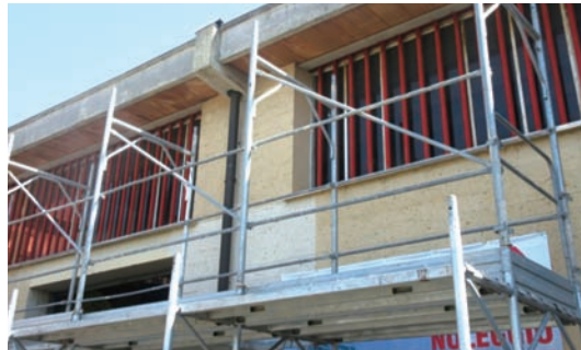
2層目の足場（手すり・中棧・斜材・幅木を取付）
