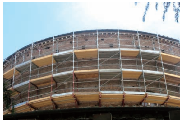
補修工事現場（外部）
