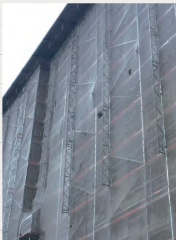
脚柱に取り付けられている梁枠
