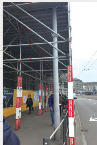
通路に架けられている足場
