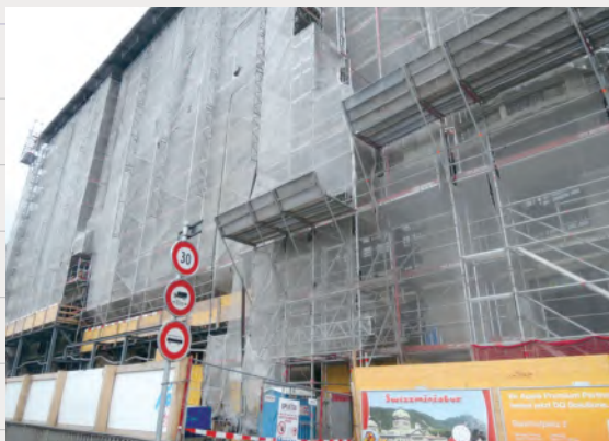
火災修繕工事の足場外観
