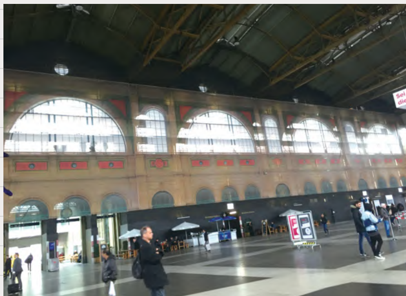
チューリッヒ駅修繕工事
