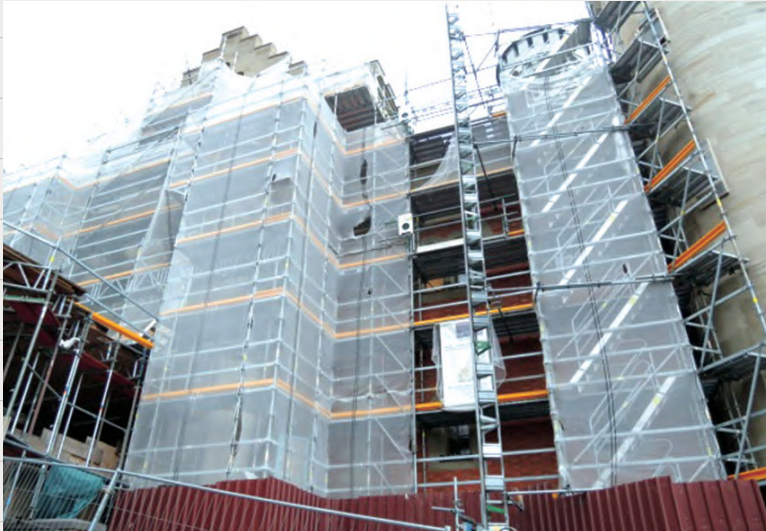
修繕工事に使用されている足場-1
