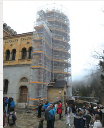
修繕工事に使用されている足場-2
