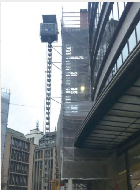
エレベーターを設置している足場
