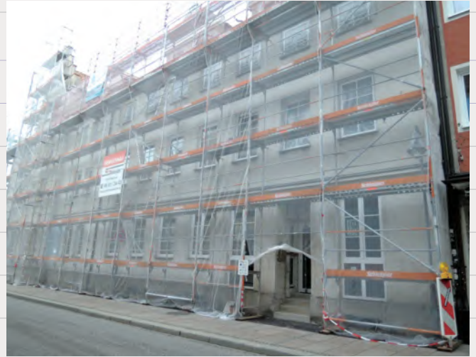
修繕工事足場外観
