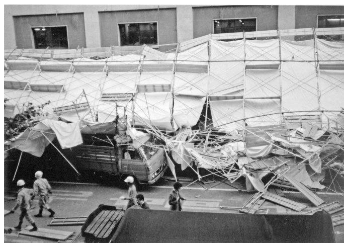
図1.1.2 強風による倒壊の例
