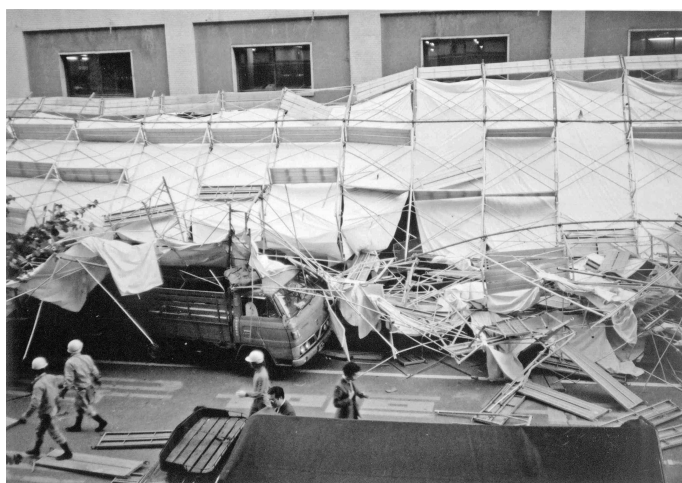
図1.1.2 強風による倒壊の例
