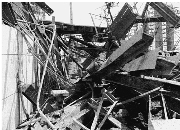
図1.1.1 支柱の座屈による倒壊の例
