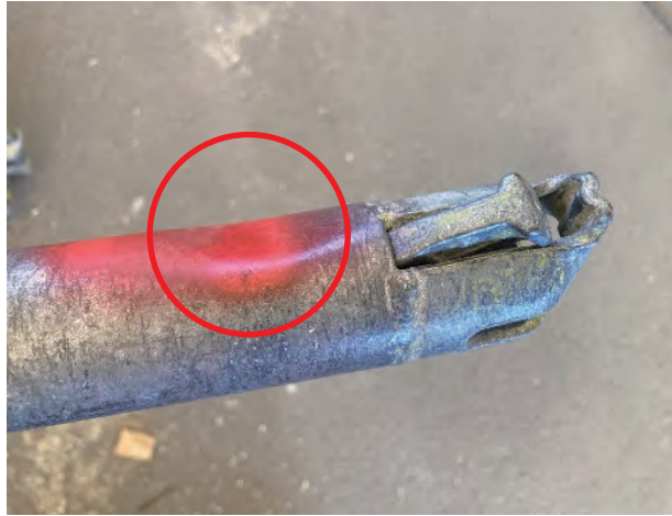
写真2-10 緊結部付布材のへこみ（廃棄）
