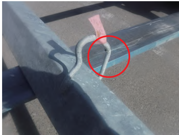
写真2-25 システム式つりだな足場のピン付デッキ サポート取手の変形と一部亀裂（廃棄）
