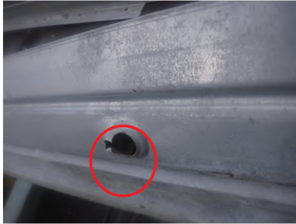
写真2-24 システム式つりだな足場の幅木の ジョイスト固定穴の亀裂（廃棄）
