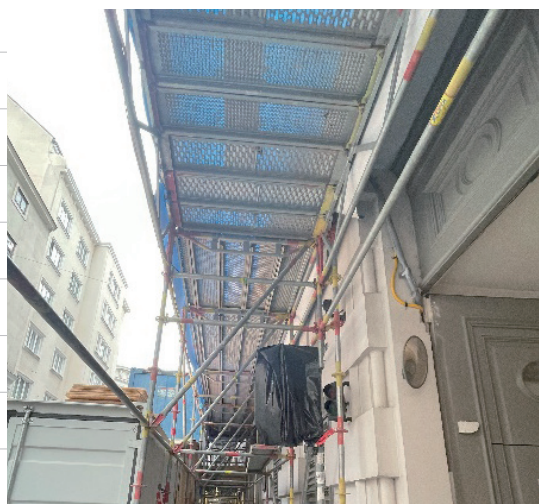
写真15 歩道直上の足場
