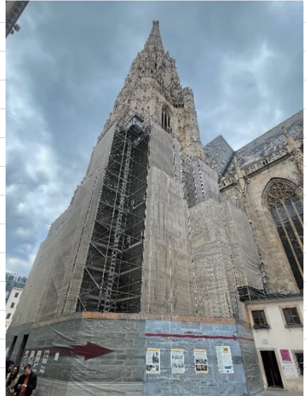
写真18 大聖堂の工事現場
