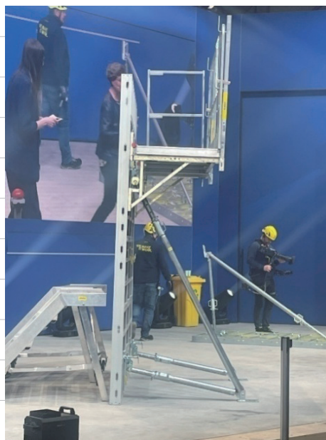
写真7 作業員1人での組み立て実演風景
