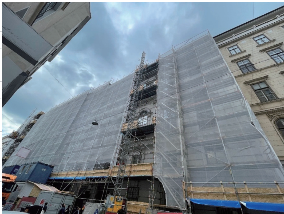
写真13 ホテル修繕工事現場
