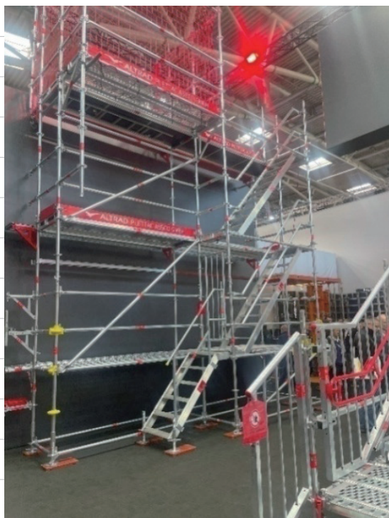
写真9 くさび緊結式足場
